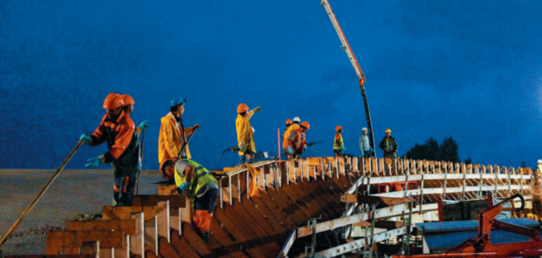
Bétonnage de la grande coque du Learning Center, juillet 2008.
