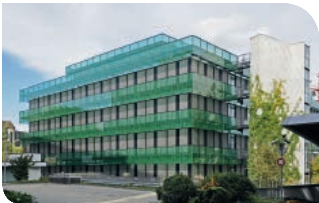
UBS AG: Gesamtanierung eines Bürogebäudes in Basel, das aus den siebziger Jahren stammt. Durch zwei Einschnitte in die bestehende Tragstruktur wurde die räumliche und funktionale Qualität der Bürozone entscheidend verbessert.
