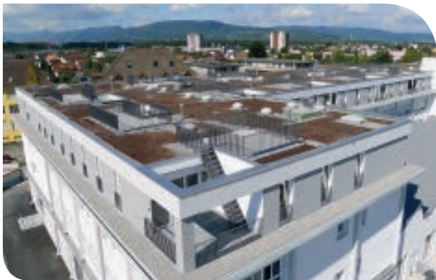
Im Flügel: Die eingeschossige Aufstockung in Holzbauweise umfasst 14 neue Wohnungen mit Loggien und Dachterrassen im nachhaltigen Quartier Im Lenz in Lenzburg (AG).
