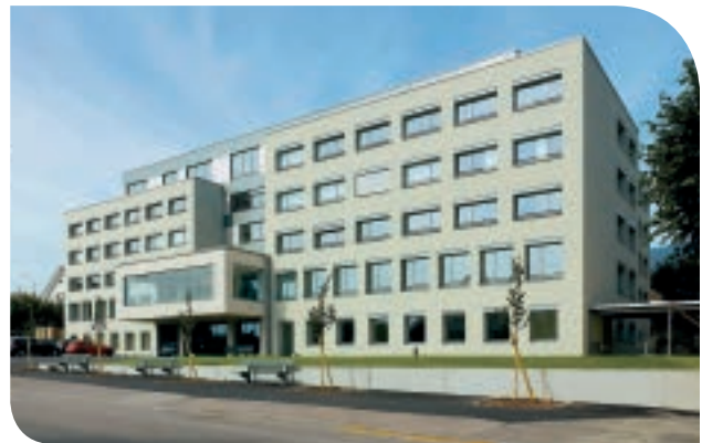
La Promenade: Umbau und Renovation eines Pflegewohnheims in Delémont (JU). Die Statik wurde wo nötig verstärkt, um die Erdbebensicherheit zu garantieren.
