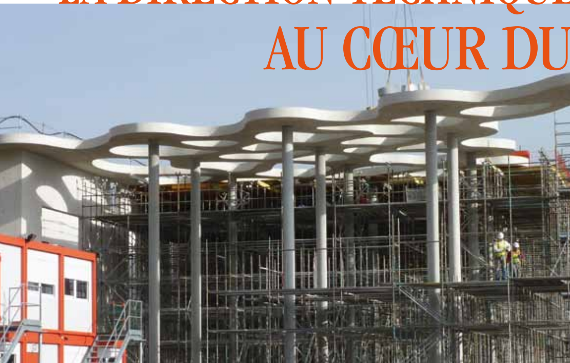
96 piliers de 9 à 18 mètres de hauteur soutiennent la canopée, feuille de béton de 40 cm d'épaisseur et de 4'500 m 2 , d'un poids de 3'000 tonnes.
