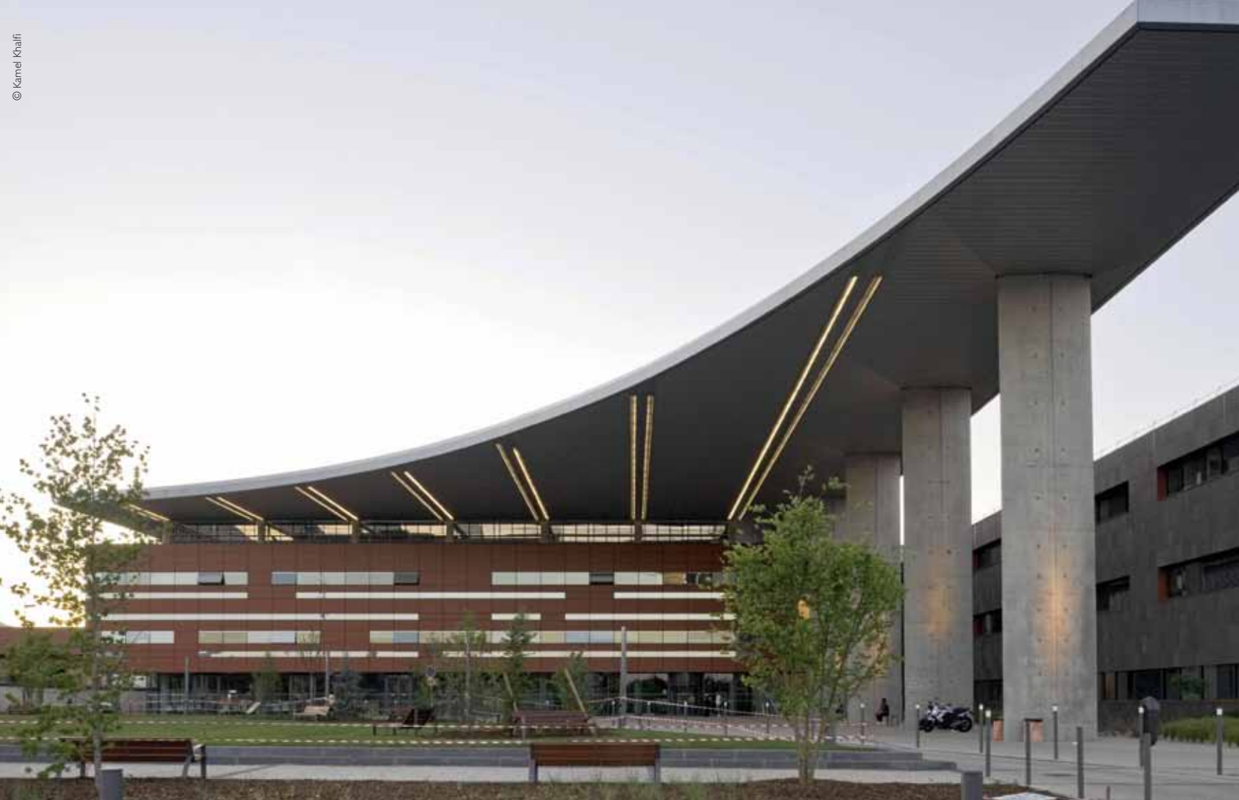
▲ Réalisé en entreprise générale, le Nouvel Hôpital d'Estaing à Clermont-Ferrand (F) a une capacité de 565 lits. Cet hôpital de 97'000 m 2 s'organise autour d'un pôle mère enfant, d'un pôle d'hébergement et d'un pôle technique comportant 14 salles d'opération. Ce bâtiment intégralement informatisé permettra notamment le développement de la médecine ambulatoire.
