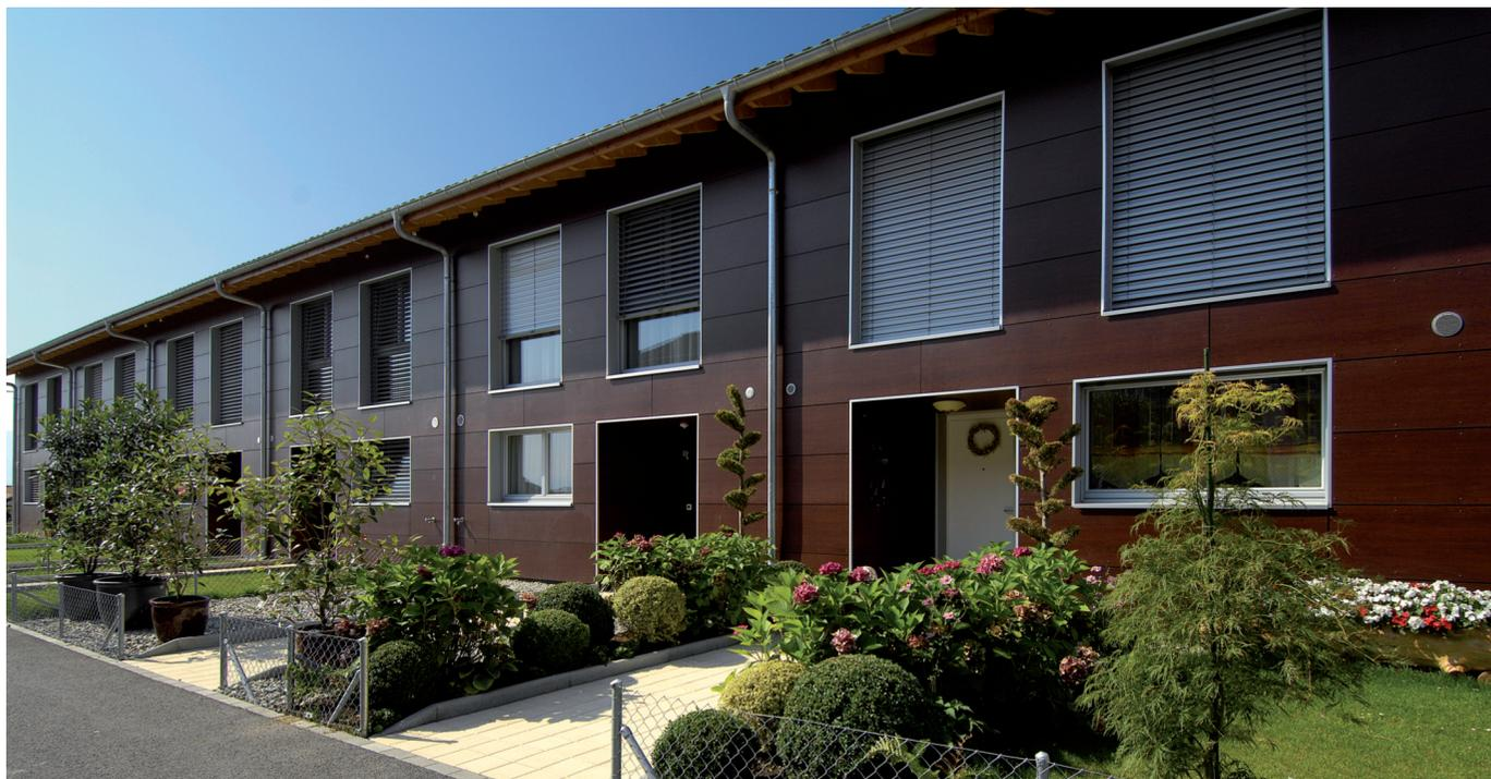
La charpente classique, réalisée en bois, supporte une isolation renforcée pour garantir de bonnes conditions phoniques, selon règlement dans la zone aéroportuaire, tandis que la couverture du toit à deux pans simples est réalisée en tuiles de terre cuite vieilles, type "Joran".
