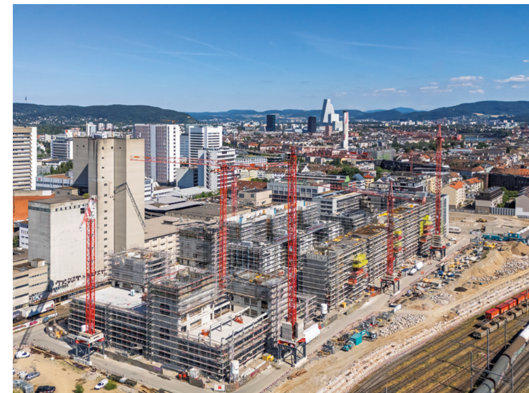
Baufortschritt beim Projekt Volta Nord in Basel, das Losinger Marazzi als Totalunternehmerin für die SBB realisiert.
